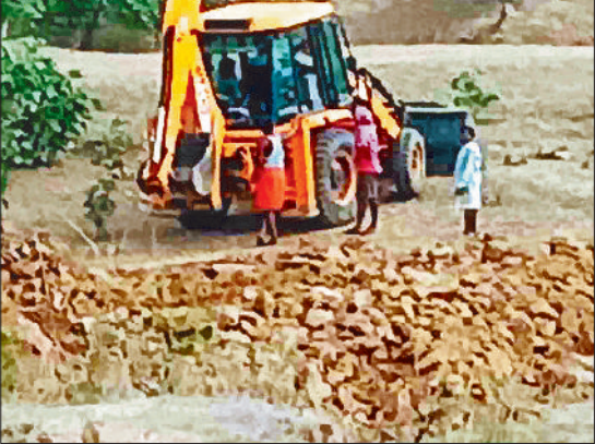
निर्माण में लगे जेसीबी।
